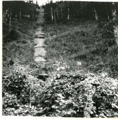
A SZIKLAFALBA ÉPÜLT FÜSTVEZETŐ CSATORNA A GÉPHÁZ MÖGÖTT.
