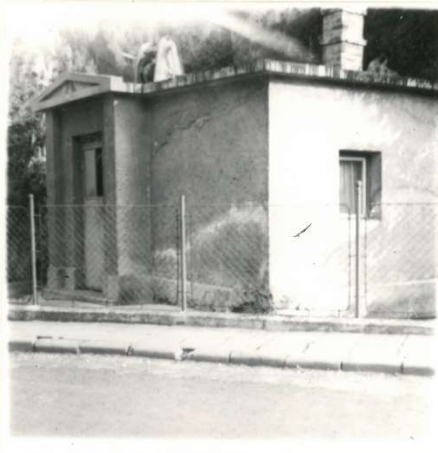
A SINTÉRKÚT SZIVATTYÚHÁZA
