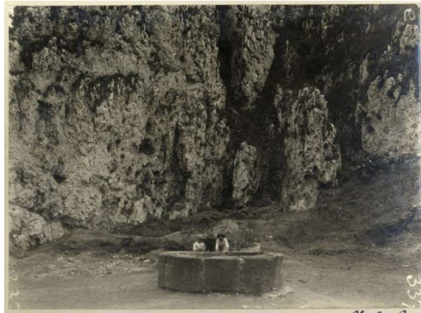
„Veszprém, dolomit sziklák és kőkávás kút a vízvezetéki szivattyú-telepnél.” Felvétel ideje: 1925. V. 25. [4.]
